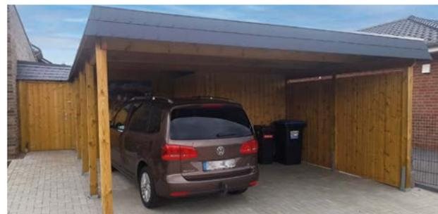
Kiefer KDI Landhauscarport mit Kammer, Seitenwänden und umlaufender Schindelwalm - Blende mit Alukante.
